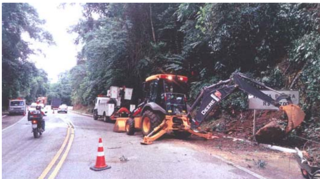
Foto 10 – Remoção de barreira Km 049+500 [2]
