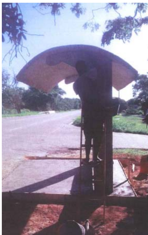
Foto 2 – Implantação de guarita de ponto de ônibus – Km 020+400 [2]
