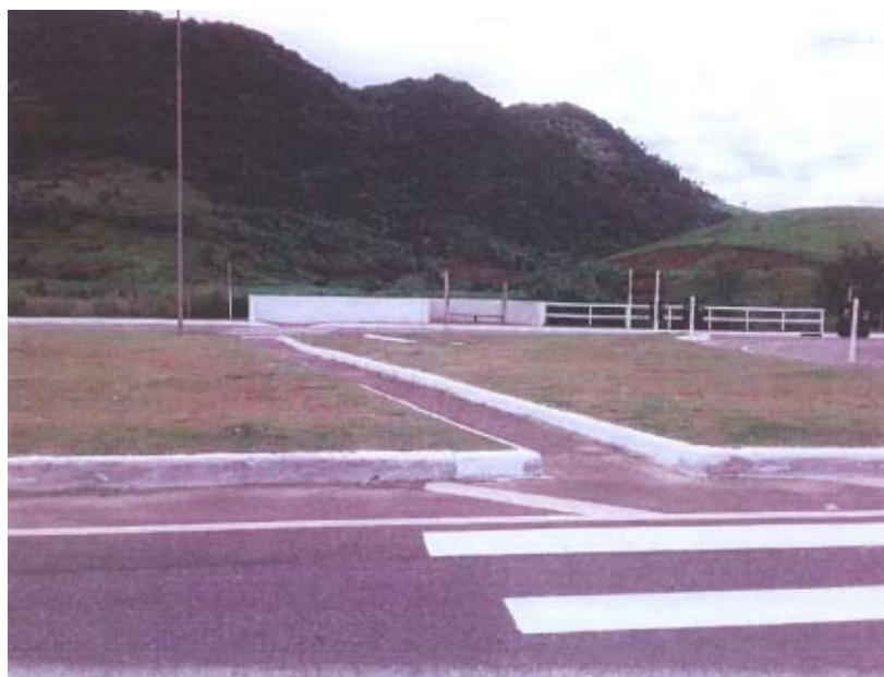
Foto 8 – Revitalização de sinalização – Km 021+200 [2]
