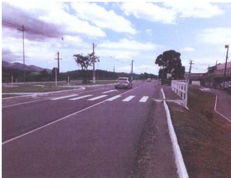
Foto 7 – Revitalização de sinalização – Km 021+200 [1]
