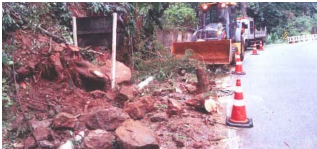
Foto 9 – Remoção de barreira Km 049+500 [1]
